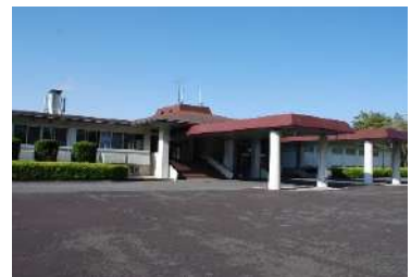
玄関(車寄せ屋根の高さ=3.9m)
