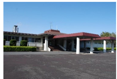
玄関(車寄せ屋根の高さ=3.9m)
