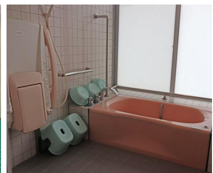
身体障害者用の浴室（引率者控室）
