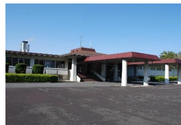
玄関(車寄せ屋根の高さ=3.9m)
