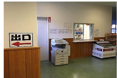
食堂事務室（食堂出口）
