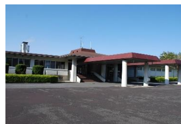
玄関(車寄せ屋根の高さ=3.9m)
